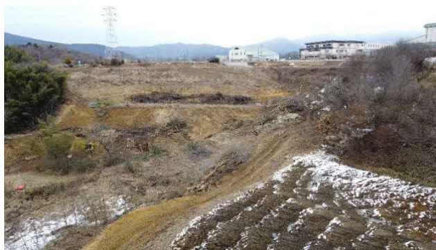
写真 伐採状況
