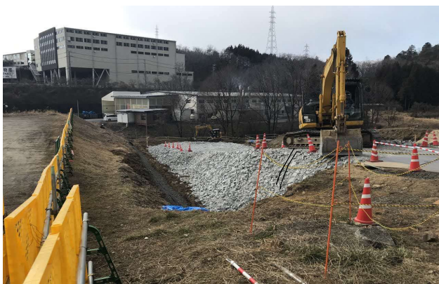
写真 盛土状況
