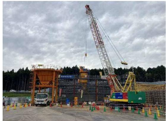
写真 ケーソン基礎工 沈下掘削状況
