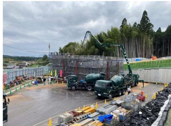
写真 コンクリート打設状況
