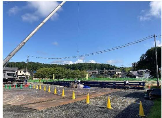
写真 仮付替道路 仮橋組立状況
