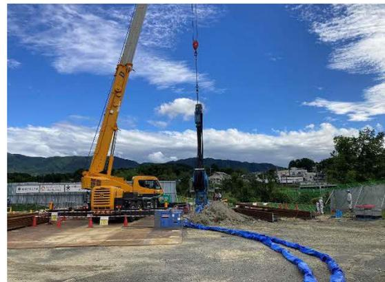
写真 河川切回し工 鋼矢板打設状況
