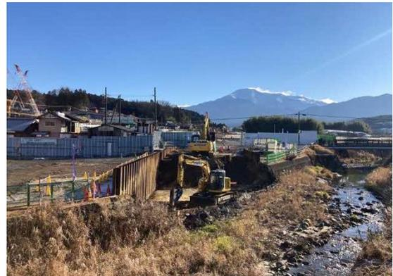
写真 仮付替河川 掘削状況
