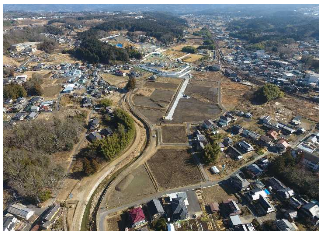
【状況写真 R5.1 月時点】
