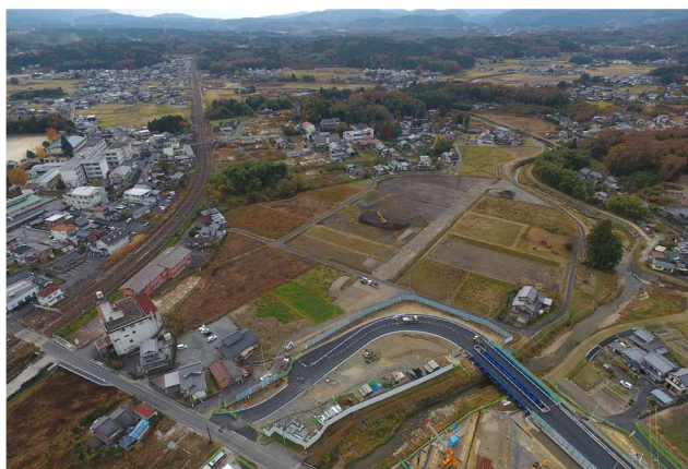
【状況写真 R4.11 月時点】
