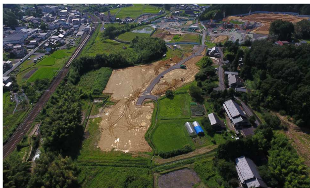
【状況写真 R4.7 月時点】
