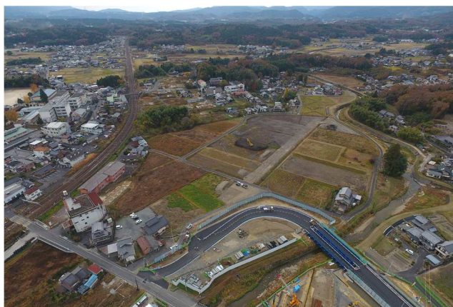
【状況写真 R4.11 月時点】
