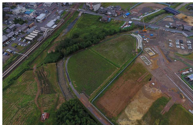
【状況写真 R4.9 月時点】
