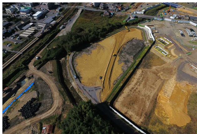
【状況写真 R4.10 月時点】
