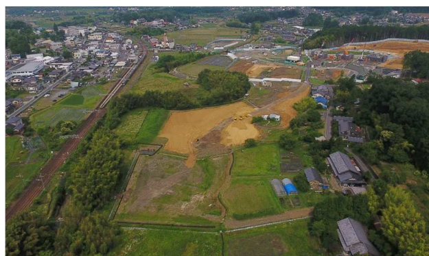
【状況写真 R4.6 月時点】
