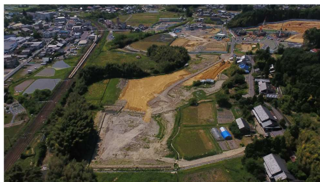
【状況写真 R4.5 月時点】
