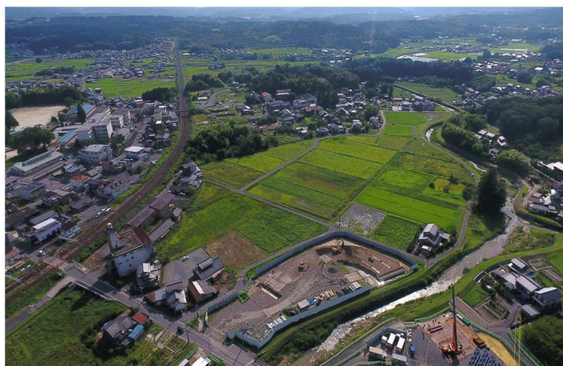
【状況写真 R4.8 月時点】
