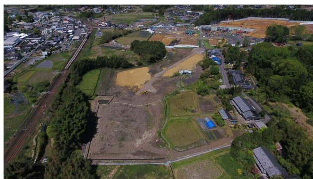
【状況写真 R4.4月時点】
