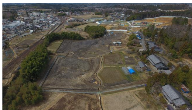
【状況写真 R4.3月時点】
