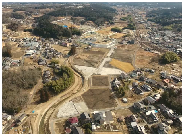
【状況写真 R5.2 月時点】
