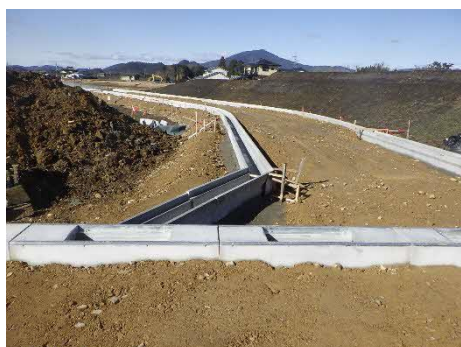
付替水路道路工事状況
