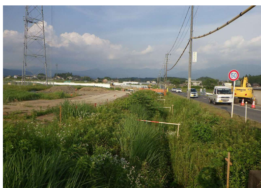
付替水路・工事用仮設道路状況
