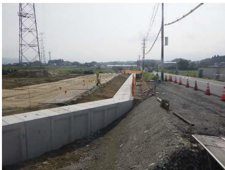
付替水路・工事用仮設道路状況
