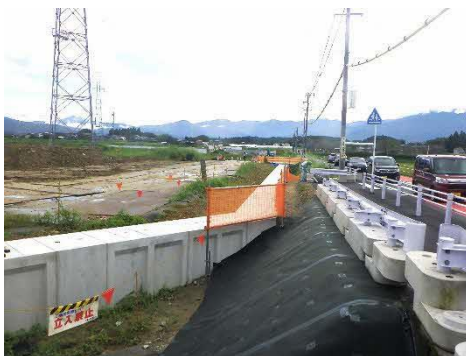
付替水路・工事用仮設道路状況
