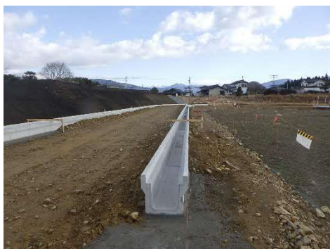
付替水路工事状況
