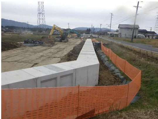
付替水路工事状況
