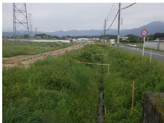
付替水路・工事用仮設道路状況
