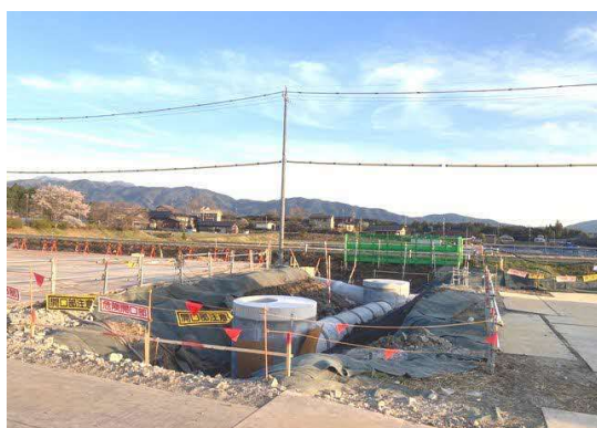
付替水路・工事用仮設道路状況
