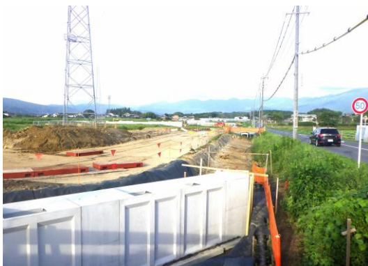
付替水路・工事用仮設道路状況
