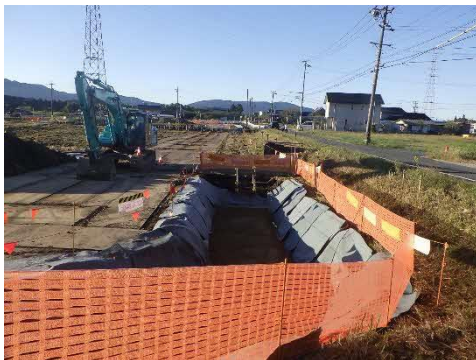
付替水路・工事用仮設道路状況
