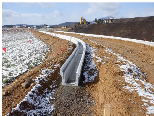
付替水路工事状況
