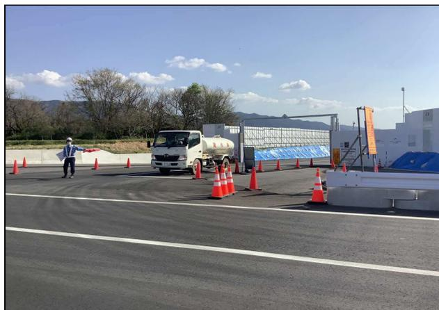
【工事用進入路仮設ゲート・仮囲い完了】
