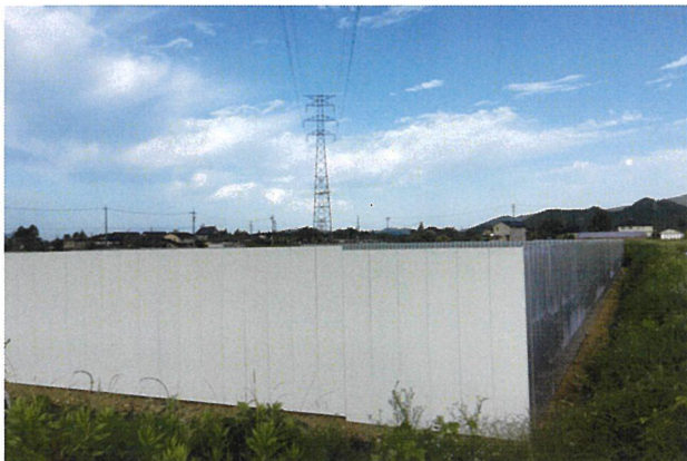
仮囲い設置工（例）
