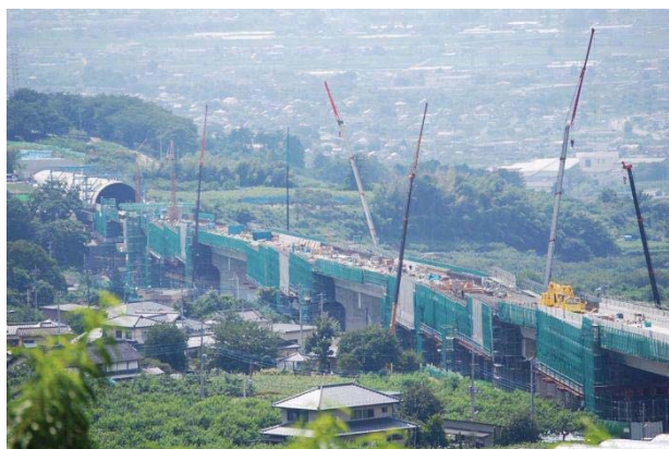
山梨リニア実験線延伸工事(山梨県笛吹市内)
