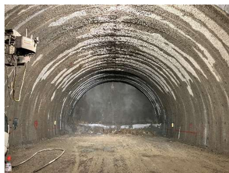
写真-1 トンネル内状況
