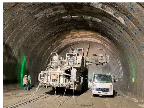
写真-1 ロックボルト施工状況
