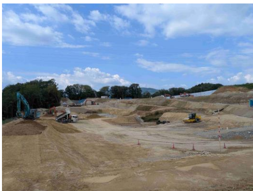
写真 現場状況
