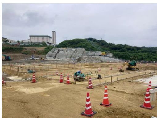
写真 土砂ピット設置位置
