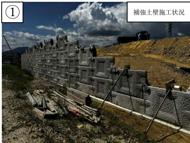
【状況写真 R8.8 月時点】
