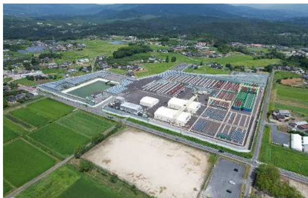
中津川ガイドウェイ資材置場現況
