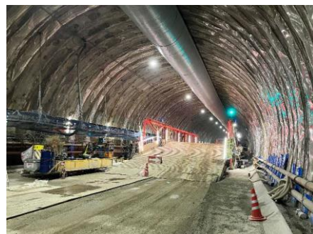
インバート施工状況
