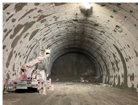
写真-1 トンネル内状況
