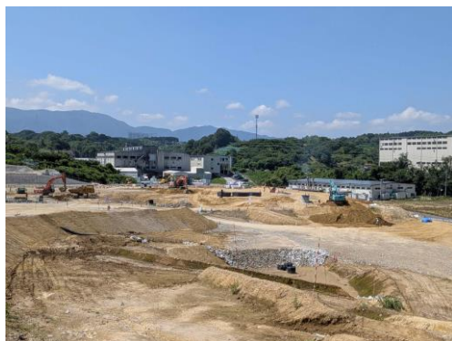
写真 現場状況
