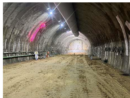
写真 トンネル坑内状況
