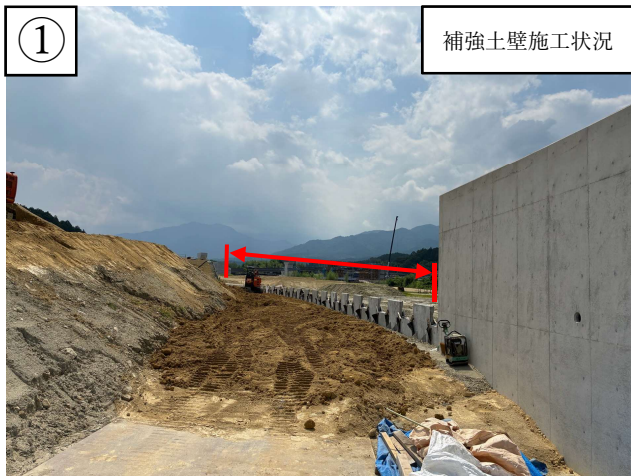
【状況写真 R8.7月時点】
