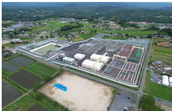
中津川ガイドウェイ資材置場現況
