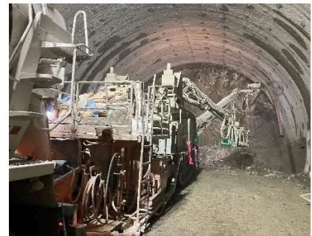
写真-1 吹付け状況
