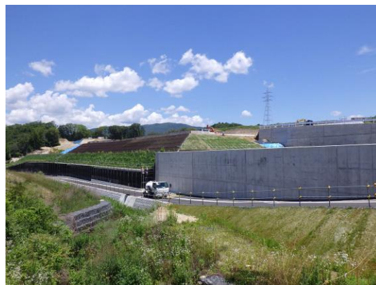
写真 盛土工(法面保護)
