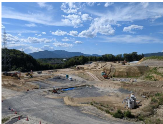
写真 現場状況
