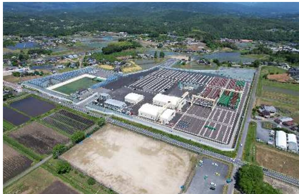
中津川ガイドウェイ資材置場現況
