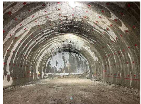
写真-1 坑内状況
