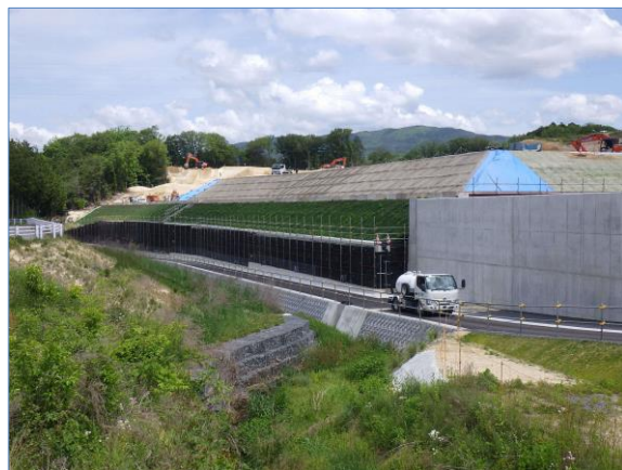
写真 盛土工(法面保護)
