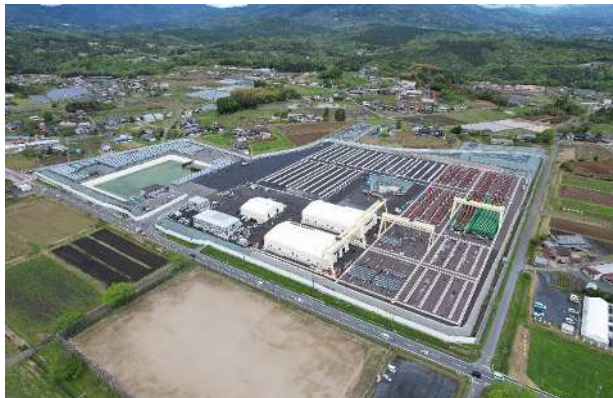
中津川ガイドウェイ資材置場現況
