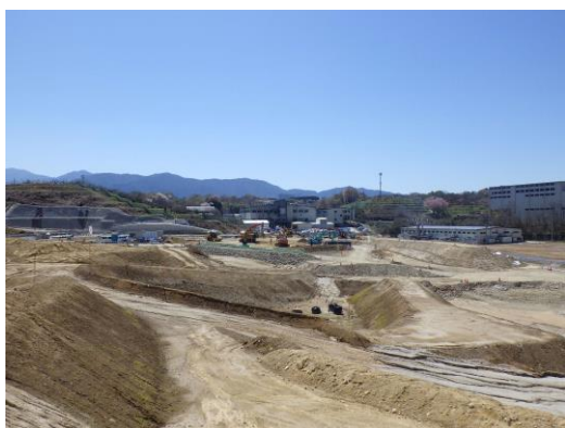
写真 造成状況
