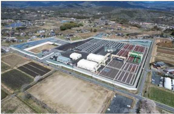
中津川ガイドウェイ資材置場現況
