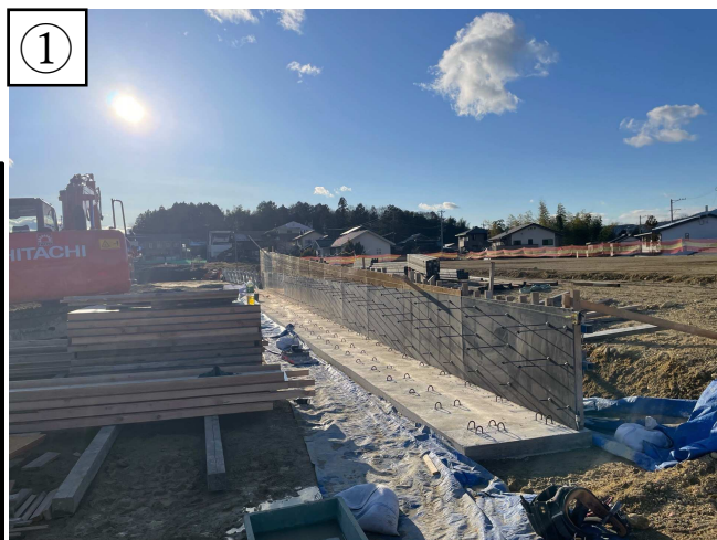
【状況写真 R8.1 月時点】
