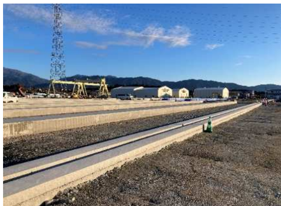
基礎工・電気部品取付 TENT 等設置
