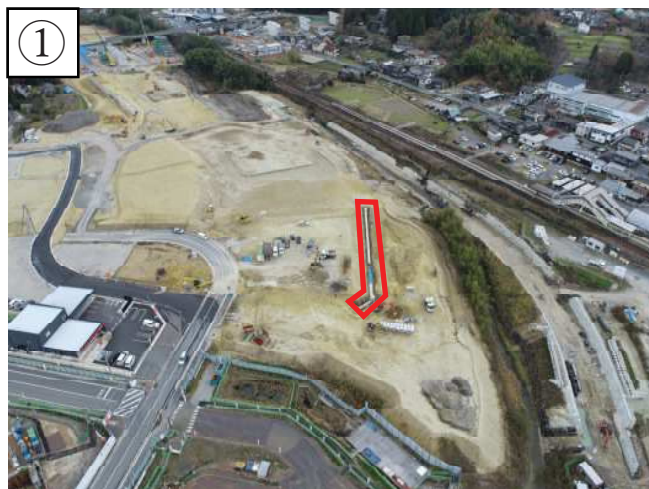
【状況写真 R7.12 月時点】
