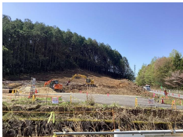
写真 回送線エリア 施工状況
