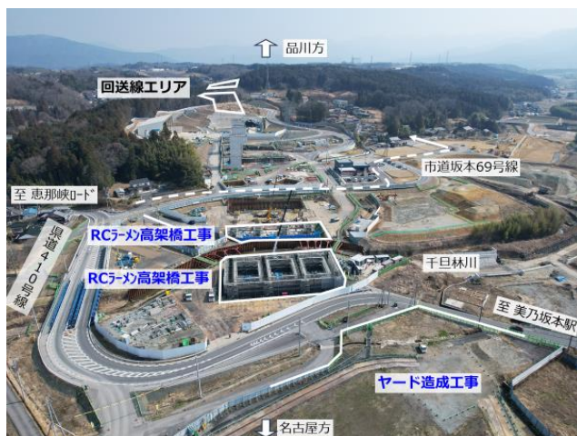
図 当月の主な工事範囲（駅東部）
