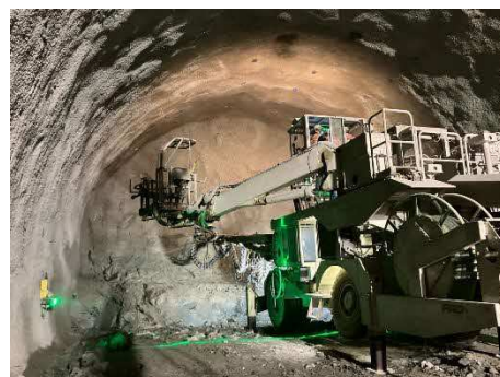
写真-1 削孔状況
