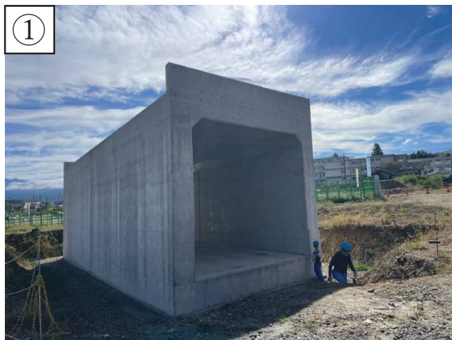
【状況写真 R7.10 月時点】
