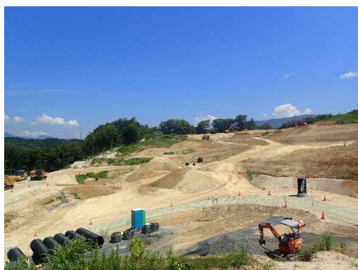
写真 盛土工（施工状況）
