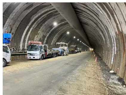
写真 トンネル坑内状況
