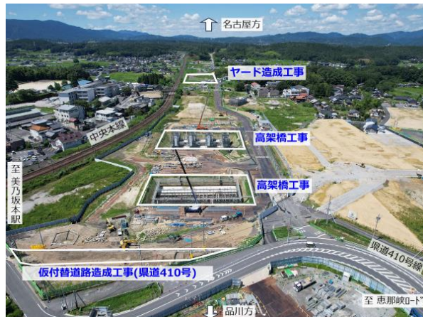
図 当月の主な工事範囲（駅中央部および駅西部）
