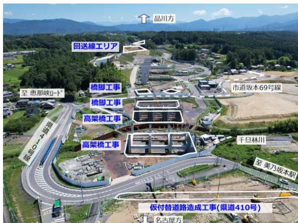
図 当月の主な工事範囲（駅東部）
