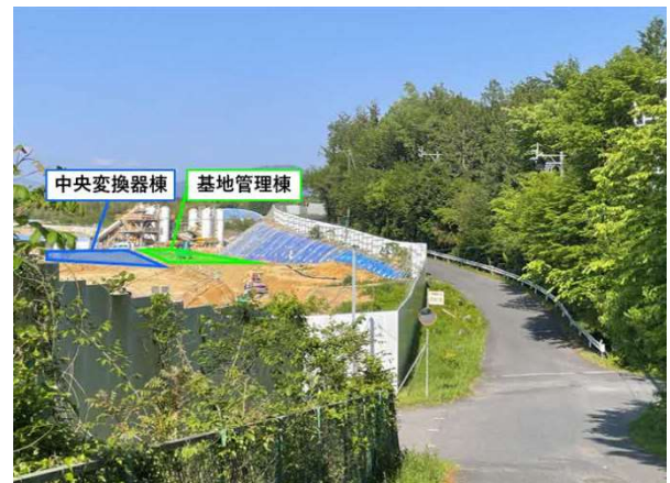
建物工事範囲 遠景写真
