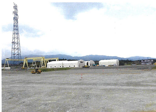
盛土工・電気部品取付 TENT 等設置
