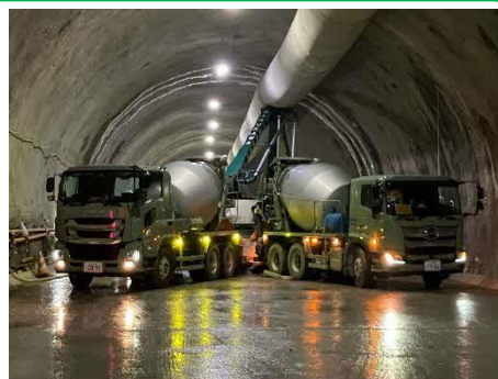
写真-1 インバート施工状況
