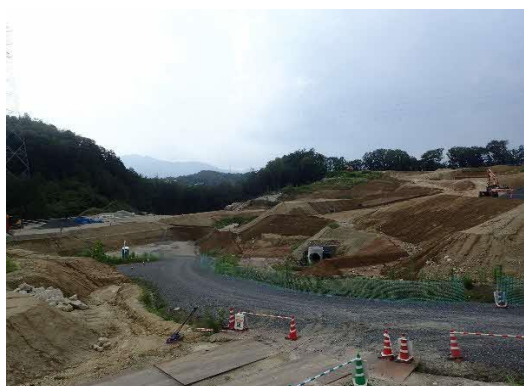
写真 盛土工（施工状況）
