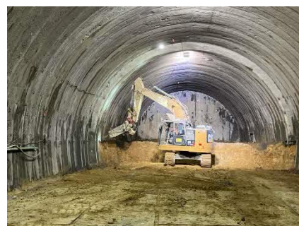
写真 トンネル施工状況
