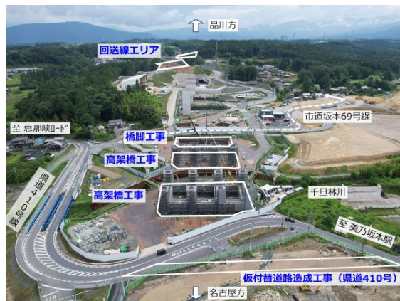
図 当月の主な工事範囲（駅東部）
