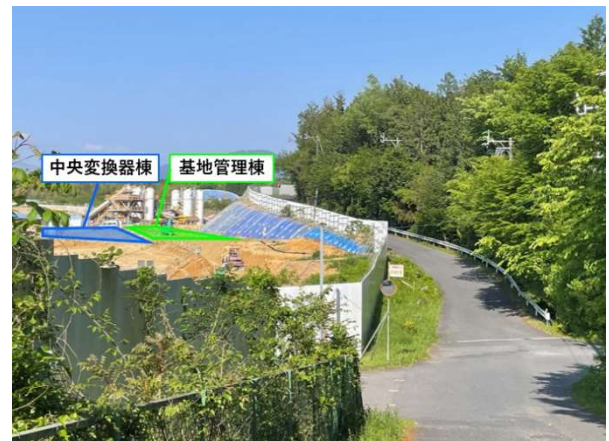
建物工事範囲 遠景写真
