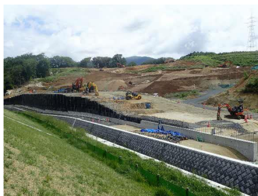
写真 擁壁工（施工状況）
