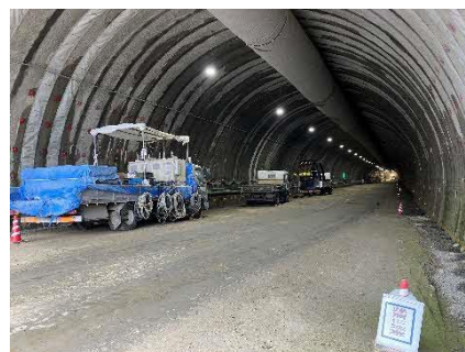
写真 トンネル坑内状況
