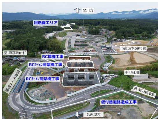
図 当月の主な工事範囲（駅東部）
