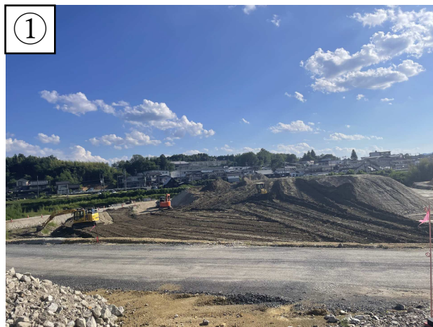
【状況写真 R7.6月時点】
