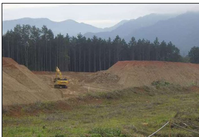
写真 車両基地エリア
