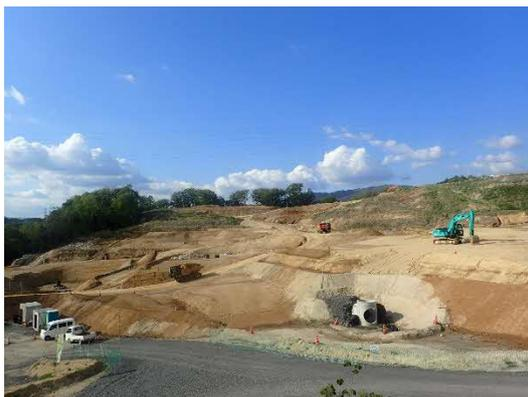
写真 盛土工（施工状況）
