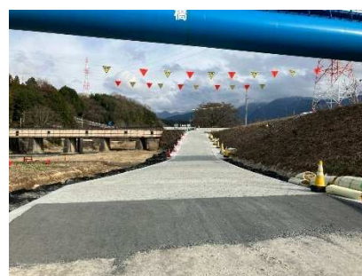
写真-1 落合河川敷施工状況
