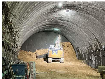
写真 トンネル施工状況
